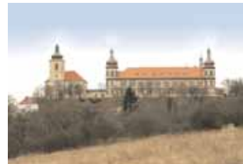
Stav po rekonstrukci
